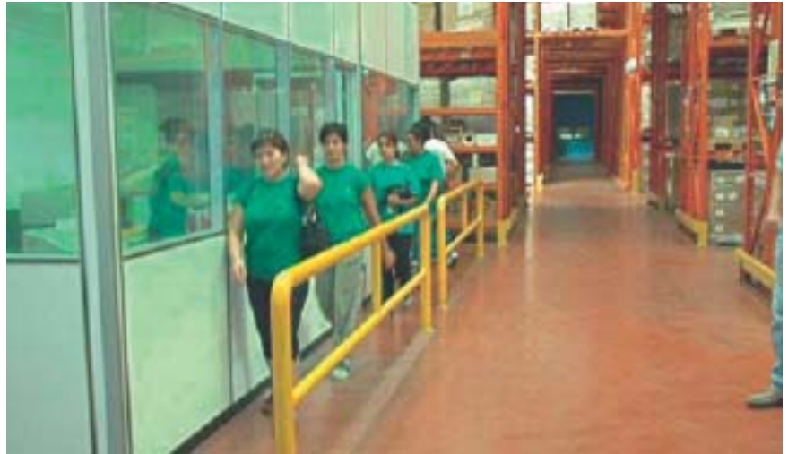
La fotografia mostra la presenza di ripari fissi posti sia in corrispondenza di passaggi pedonali frequentati che a protezione delle scaffalature
