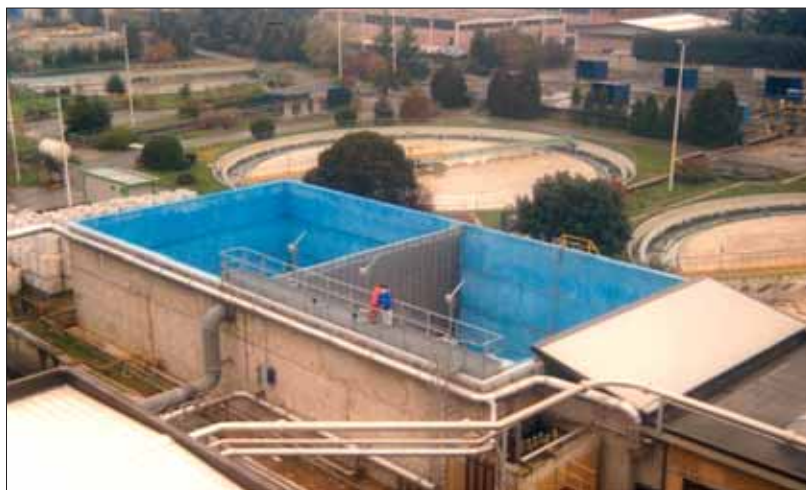
L'impianto basato sulla tecnologia MBBR in funzione alla Asm-Bas di Bergamo
